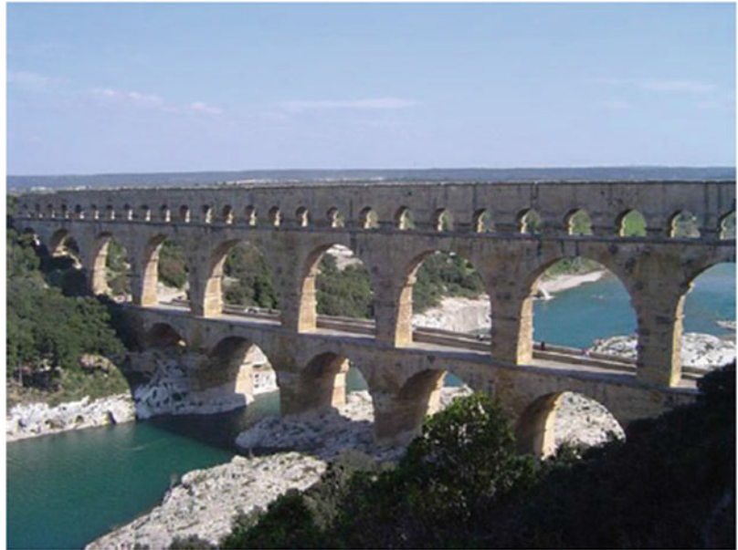
Fig. 6.4 Pont du Gard crossing
